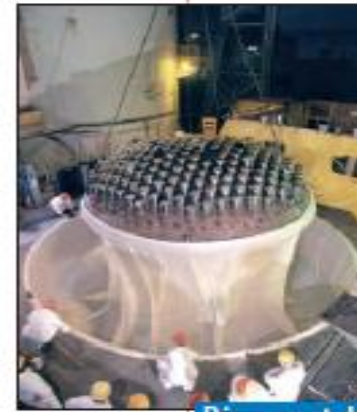
Découpe et dépose du couvercle supérieur du réacteur après confinement
