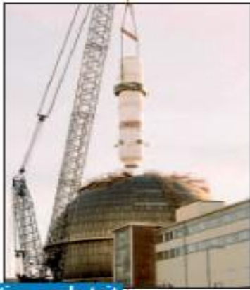
Extraction par le toit des 4 échangeurs de 100 t chacun (voir aussi page de couverture)
